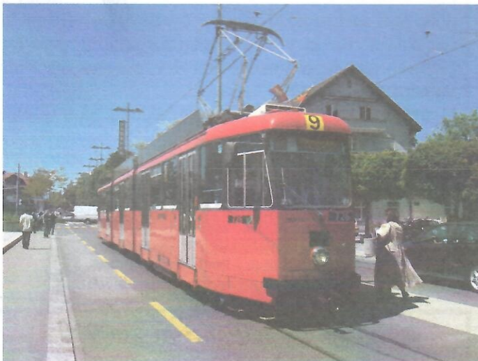
Voie principale avec tram sur chaussée à Köniz
